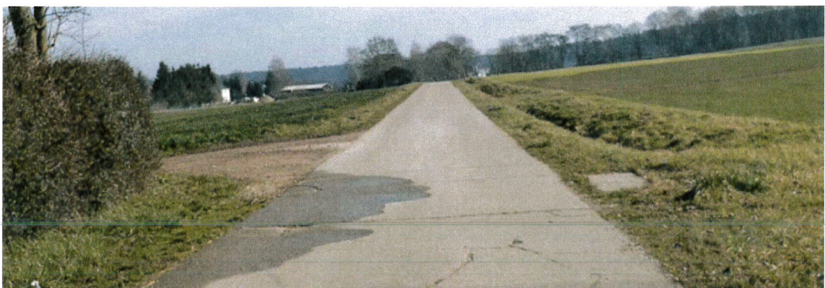
Abbildung 7 Aktueller Zustand des Weges (MKZ 116 327)
