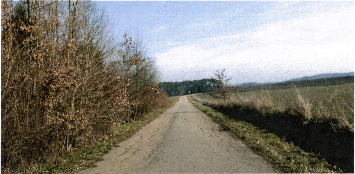
Abbildung 9 Aktueller Zustand des Weges (MKZ 116 441)
