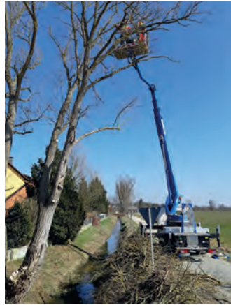
Torturm in Seligenporten: Renovierung der Turmuhr und des Dachstuhls
