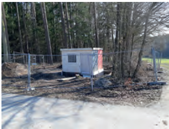
Sanierung des Übergabepumpwerks Neuhof
