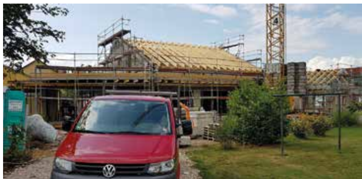
Die Marktgemeinde Pyrbaum erweitert den evangelischen Kindergarten Regenbogen in Pyr- baum um eine Krippen- und eine Regelgruppe; die Fertigstellung ist im Frühjahr 2020 geplant.
