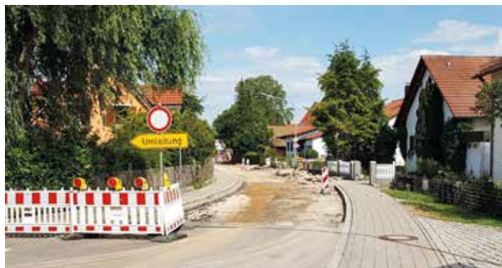
Seit 24. Juli 2019 erneuert der Landkreis die Ortsdurchfahrt der Kreisstraße NM 6 in Pyrbaum (Neumarkter Straße), in dessen Zug die Marktgemeinde u.a. den südlichen Gehweg und die Wasserleitung erneuert sowie einen neuen Regenwasserkanal und Glasfaseranschlüsse einbringt.
