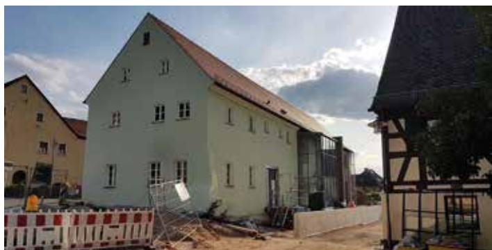
Die Gestaltung der Außenanlagen um die ehemalige Gaststätte „Bräustuben“ ist in vollem Gang.
