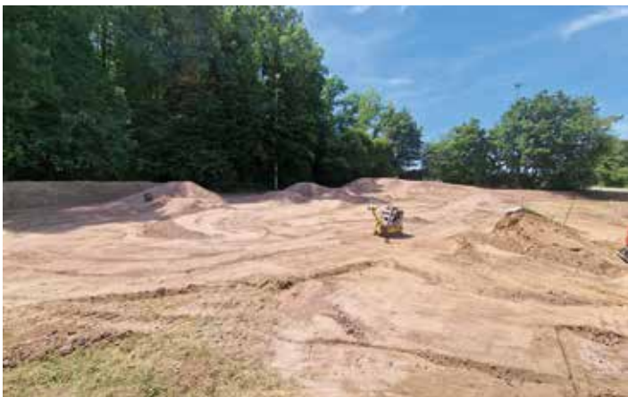
Erdarbeiten bei der Freizeitanlage in Pyrbaum
