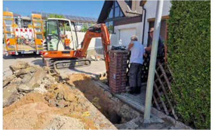
Kabelschaden in der Windmühle behoben
