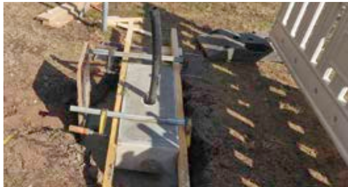
Fundamente für eine Infotafel an der Schule in Seligenporten gelegt
