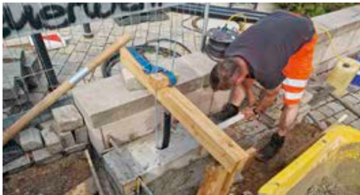
Fundamente für eine Infotafel am Marktplatz gelegt
