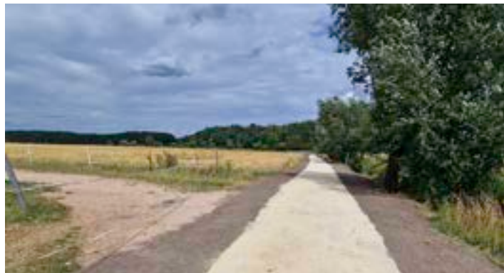
Geh- und Radweg in Seligenporten entlang der Schwarzach wurde fertiggestellt
