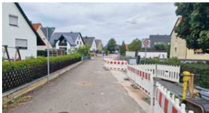
Königsberger Straße: Wasserleitungen erneuert
