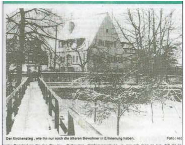
Bild ca. 1960 - Der Steg ist noch intakt Dahinter des Haus "Dr. Preuß", Steg erbaut 1761 – Bild 16
