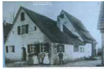
Bild 5 - ehem. Haus Kärgelein Pyrbaum (Straßbach)
