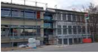
Beginn Bauarbeiten Sanierung Grundschule BA II
