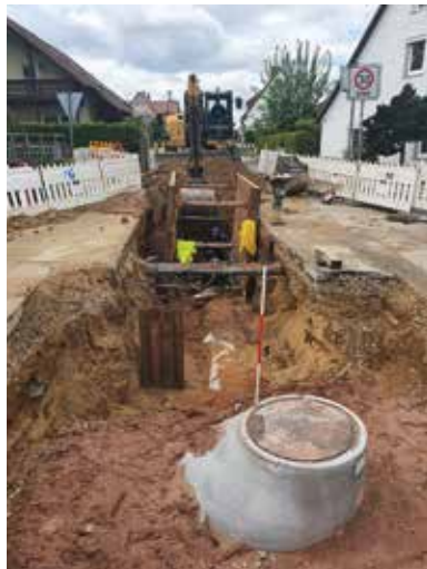
Schulstraße: Ausbau der Schulstraße, Kanalbauarbeiten
