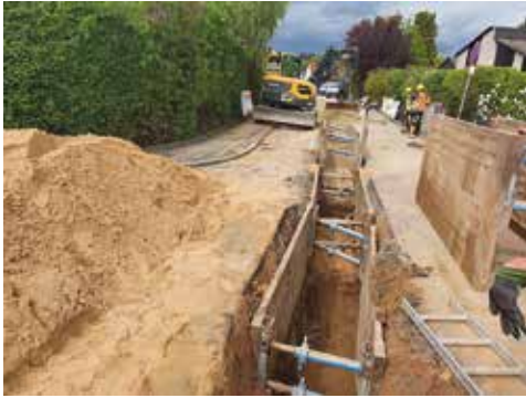
Adlerstraße: Erneuerung der Wasserleitung in der Adlerstraße
