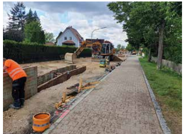
NM6: Baustelle Neumarkter Straße
