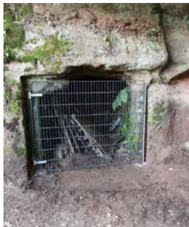
Sperrung der Eingänge an den Kellern am Festplatz in Pyrbaum
