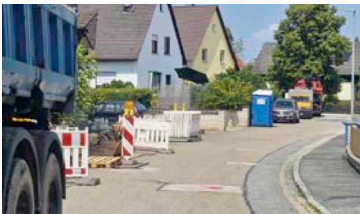
Erneuerung Gehsteig und Wasserleitung in der Königsberger Straße
