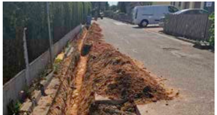
Verlegung der Stromzuleitung zur Schule in der Windmühle
