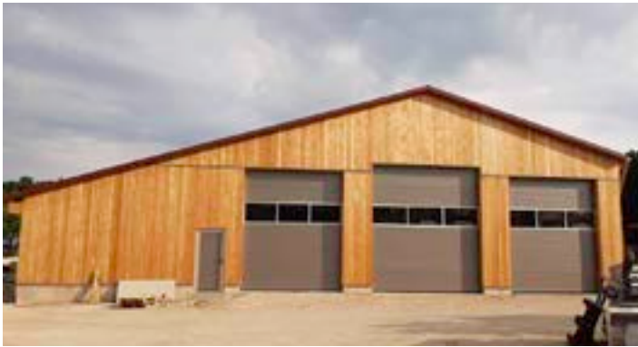
Tore zur Erweiterung der Salzhalle eingebaut
