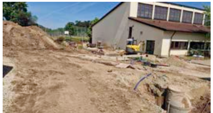
Baubeginn Bauabschnitt 2 der Schule
