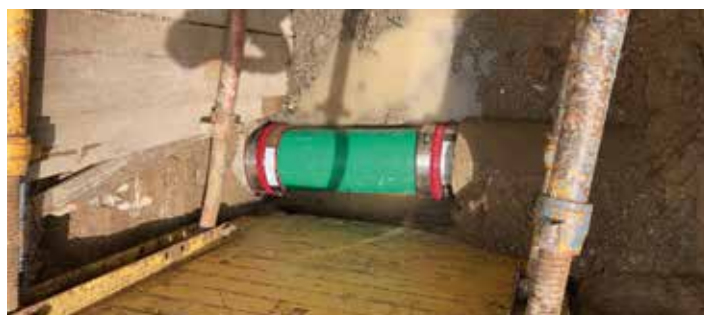
Tulpenweg: Reparatur des Kanals
