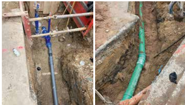
Gartenstraße: Erneuerung der Wasserleitung und Reparatur des Kanals
