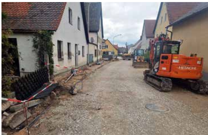
Allersberger Straße: Straßenbauarbeiten
