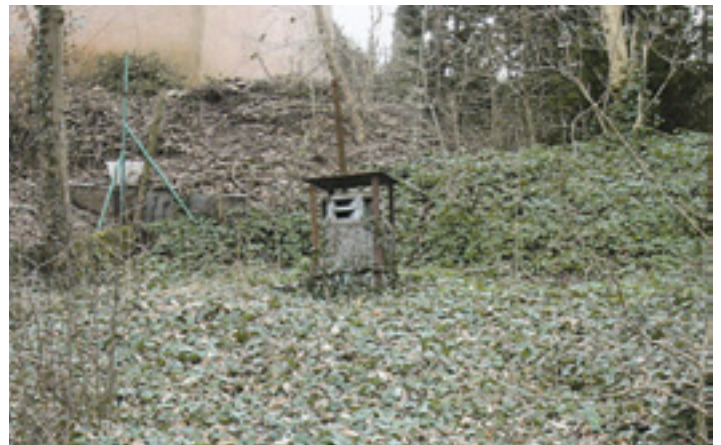
Das ehemalige Eiseinwurfloch mit Belüftungsöffnung
