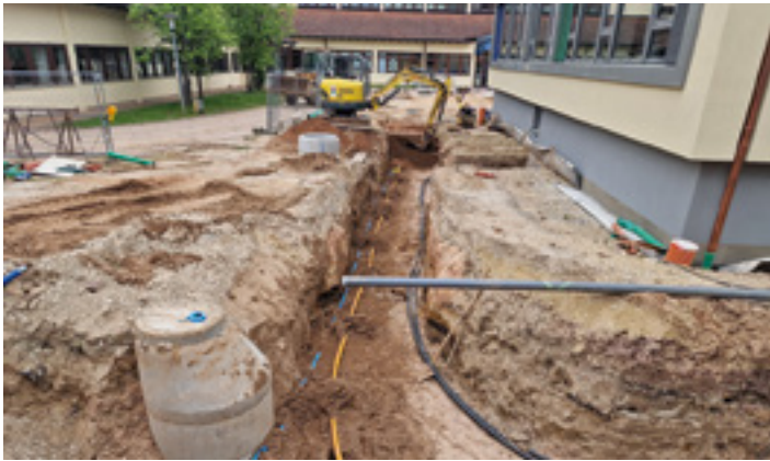
Erschließungsarbeiten Schule Pyrbaum
