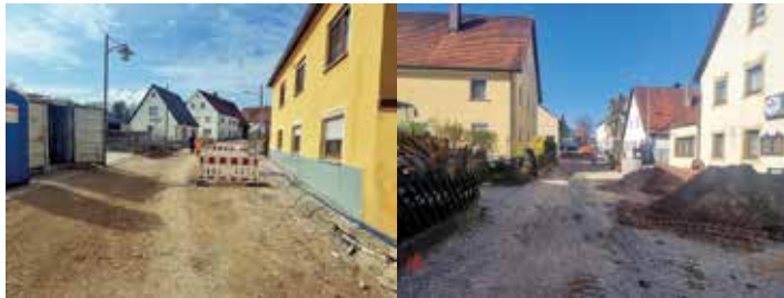
Gartenweg: Vorbereitungsarbeiten zum Anschluss von Wasser- und Kanalleitungen
