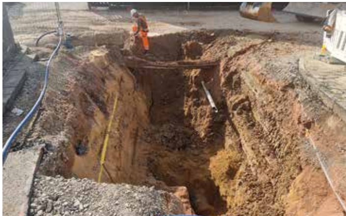
Kirchenweg – Gartenstraße in Rengersricht: Verlegung der Wasserleitung
