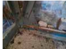
Korrosionsschäden Glockenstuhl
