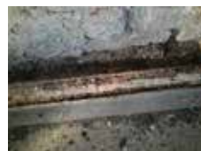
Korrosionsschäden Glockenstuhl
