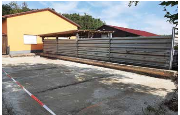
Herstellung neuer Lagerboxen für den Bauhof
