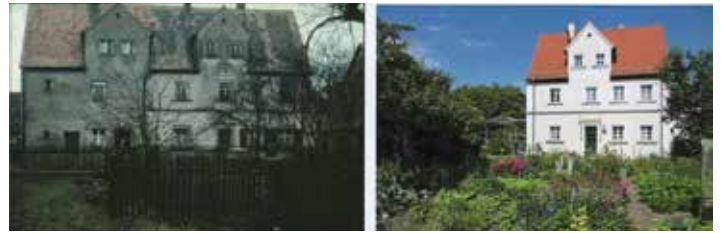
In den 20er Jahren wurde offensichtlich das Stallgebäude ausgebaut und aufgestockt - linkes Bild. Ca. um 1990 wurde das Haus generalsaniert und es entstand das jetzige Wohnhaus - rechtes Bild.
