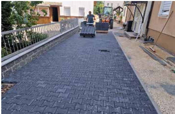
Pflasterarbeiten im Gartenweg
