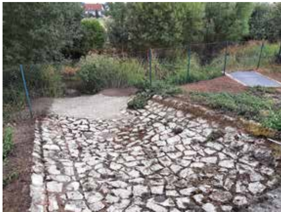
Schwarzacher Straße: Überlaufrinne am Pumpwerk erneuert
