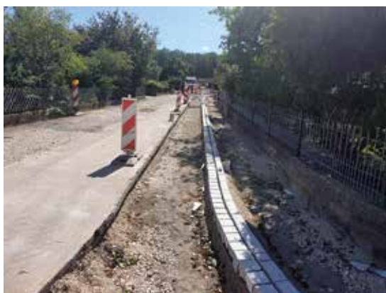
Baustelle Adlerstraße, Erneuerung Gehweg
