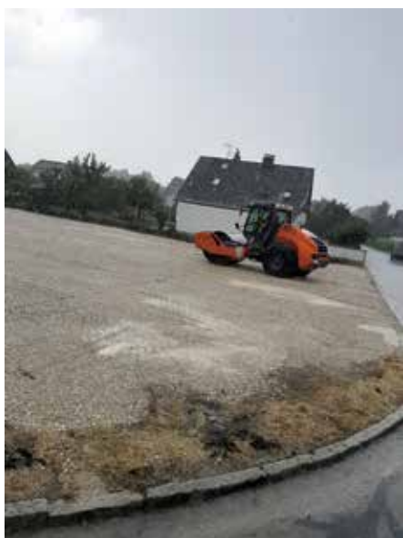
Errichtung eines Parkplatzes in der Sudetenstraße
