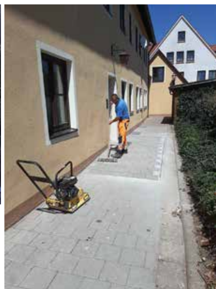
Eingang zum Rathaus wurde höhengleich umgebaut
