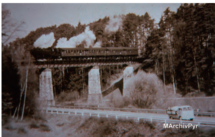
Oben: Brücke über die B 8 bei Unterferrieden, ca.1960
