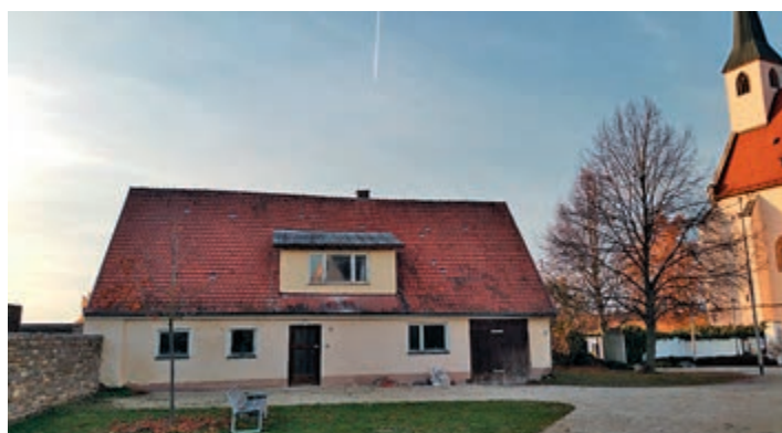
Im September beginnt die Sanierung des denkmalgeschützten Anwesens „Klosterhof 14“ (sog. „Schusterhaus“)
