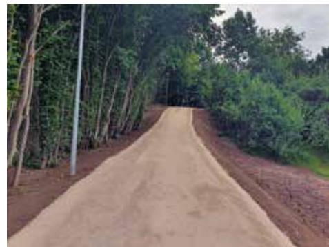
Fußweg „Am Alten Forsthaus“
