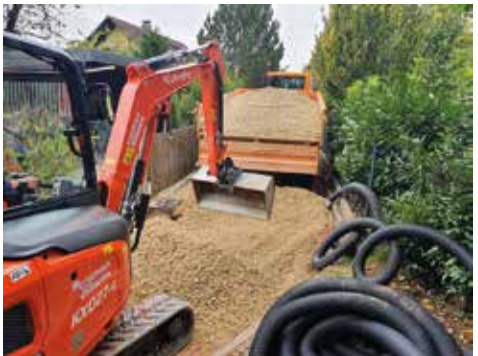
Zufahrt zum Spielplatz Sudetenstraße wird durch den Bauhof erneuert
