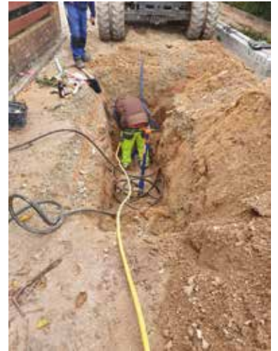
Umbindung Wasserleitung Kreuzung Meisenweg Adlerstraße
