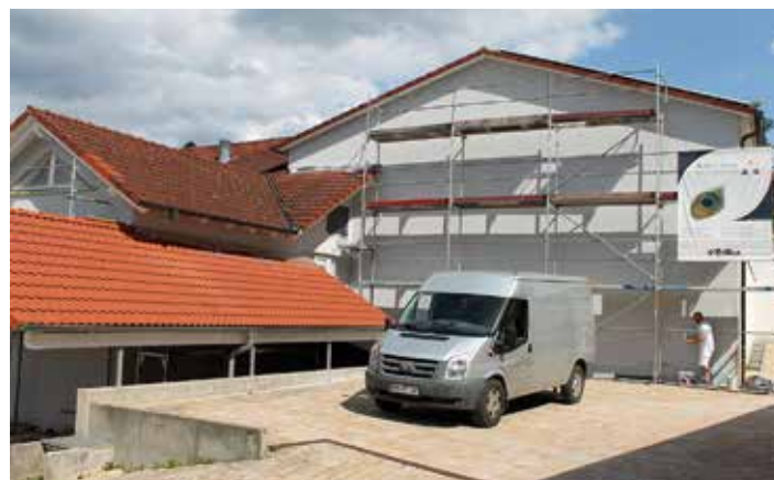
Die Außenfassade der TSV-Turnhalle, hier die Giebelansicht, erhält einen neuen Farbton, die Untersichtschalung bekommt ebenfalls eine Überarbeitung.
