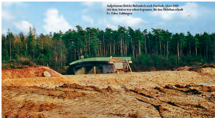
Bild aus dem Jahre 2000 – Die aufgelassene Brücke der Forststr. Birkenlach - Harrlach. Für die Verlängerung über die Bahn waren bereits Fundament gegossen und ein Kran stand schon bereit.
