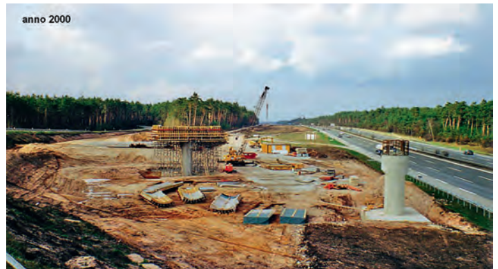
Bild aus 2001 – Die Brücke für Staatsstr. Allersberg – Sperberlohe über die BAB im Bau.
