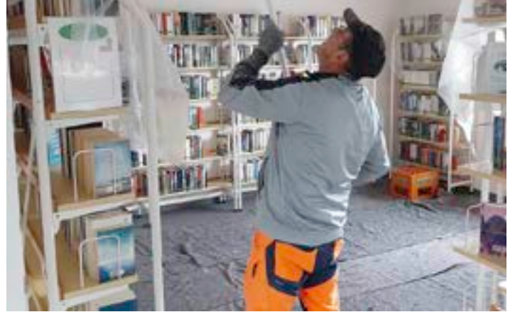
Renovierungsarbeiten in der Bücherei
