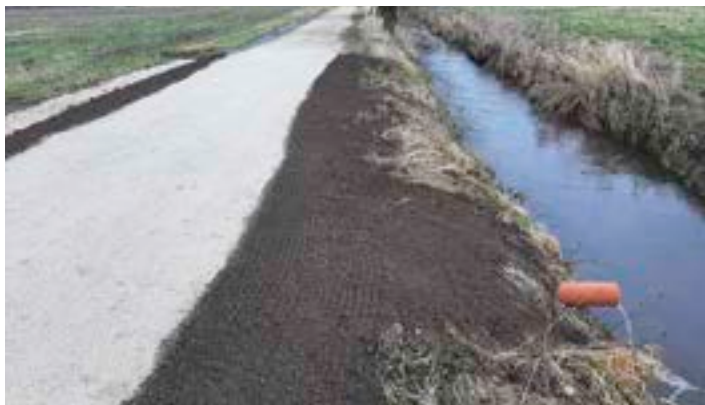
Errichtung einer Dränage am Radweg vor Seligenporten.
