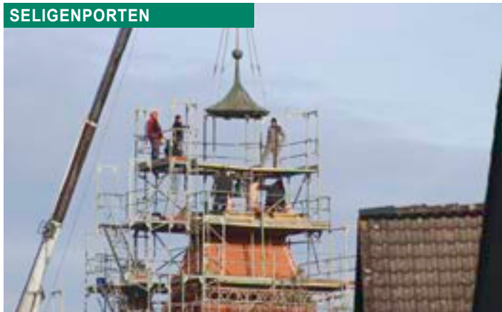
Das Dach wurde auf dem Torturm wieder aufgesetzt: Bild: Gerti und Gerhard Schöll.
