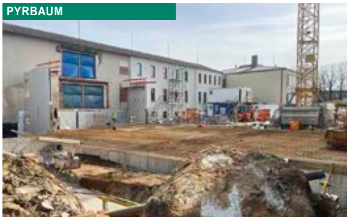
Der Umbau der Schule geht voran
