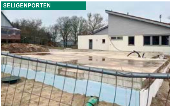
Die Bodenplatte für den Anbau der Kinderkrippe im Kindergarten Rasselbande wurde gebaut
