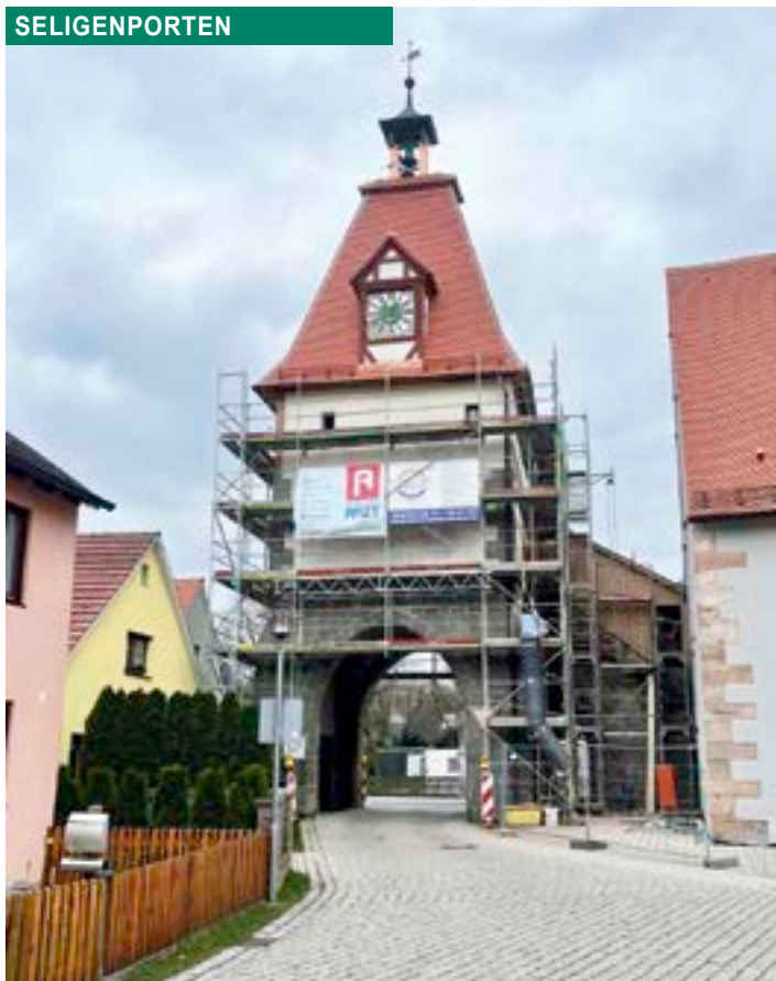
Die Renovierungsarbeiten am Torturm in Seligenporten schreiten voran
