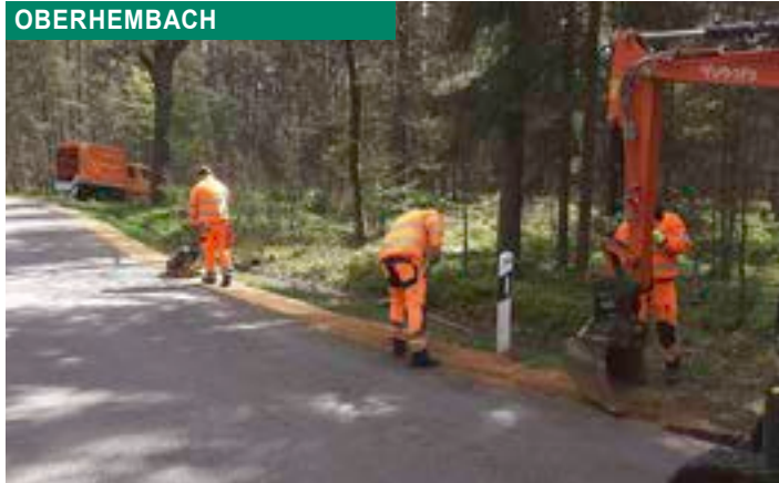
Bankette zwischen Oberhembach und Lindelburg erneuert
