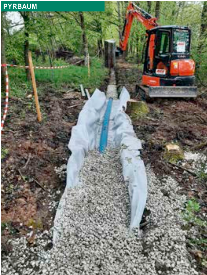
Drainage für Waldkindergarten errichtet
