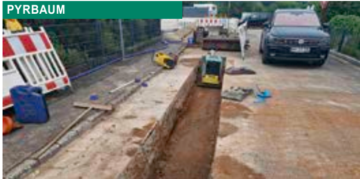
Die Wasserleitung in der Espanstraße wird erneuert
