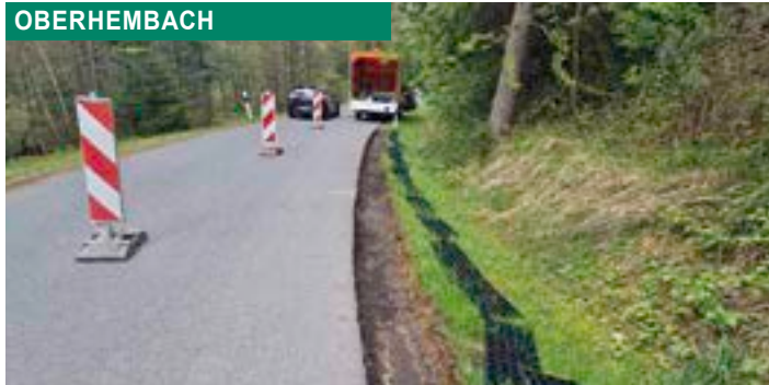
Die Bankette der Gemeindeverbindungsstraße von Oberhembach nach Lindelburg wurden befestigt
