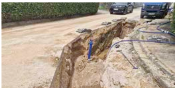
Bauarbeiten in der Espanstraße
