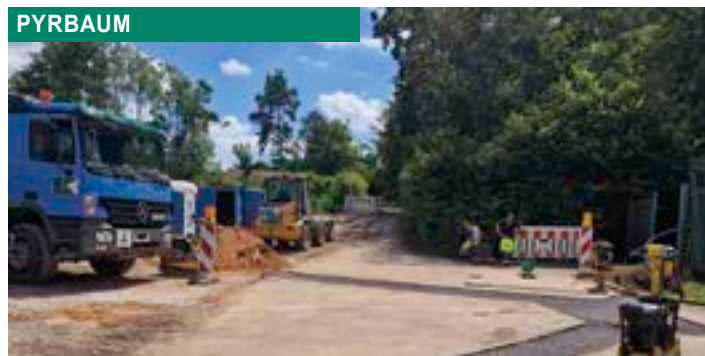
Fläche für den Waldkindergarten wird vorbereitet
