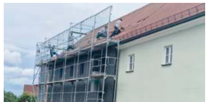
PV-Anlage wird auf dem Dach des Bürgerhauses Bräustuben gebaut
