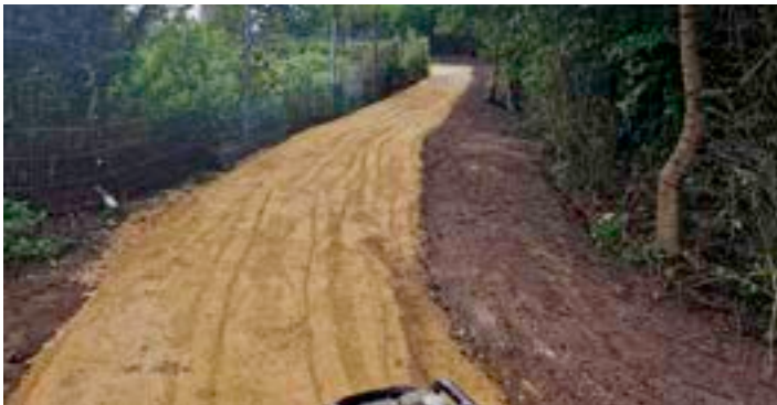
Verbindungsweg von der Schule zur Freizeitanlage und zum Sportplatz angelegt
