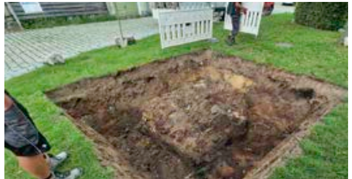
Brunnen im Klosterhof wird saniert
