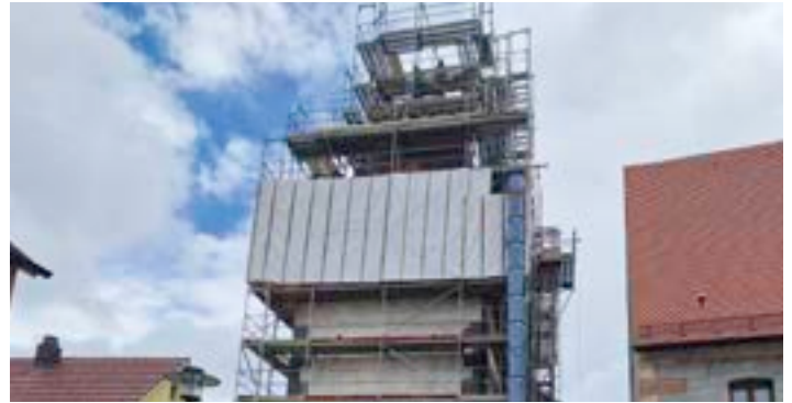
Sanierung des Dachstuhls im Torturm
