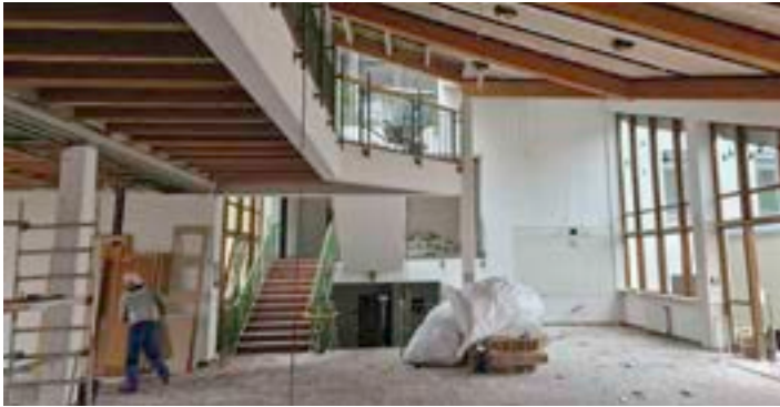
Entkernung und Abriss des Mittelbaus der Schule
