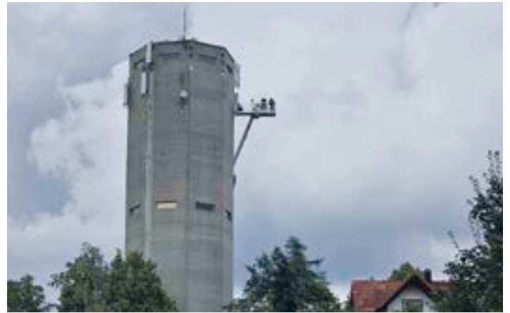
Umbau der Sendeanlage am Wasserturm zur Verbesserung der Netzqualität
