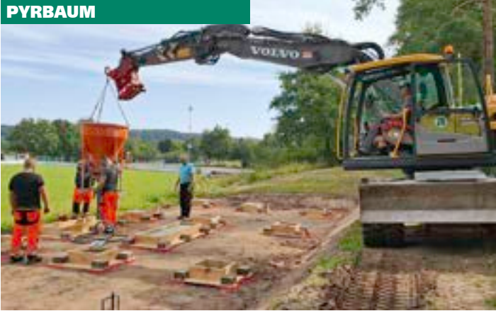
Fundamente betoniert für Waldkindergarten
