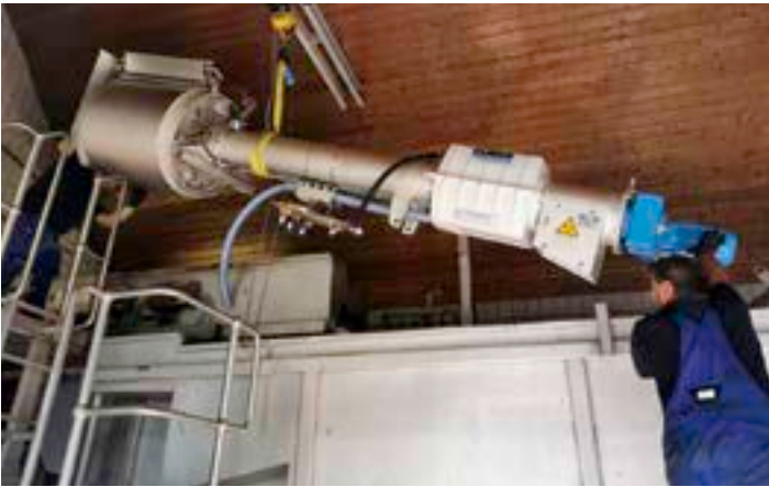
Erneuerung der Siebanlage in der Kläranlage Pyrbaum
