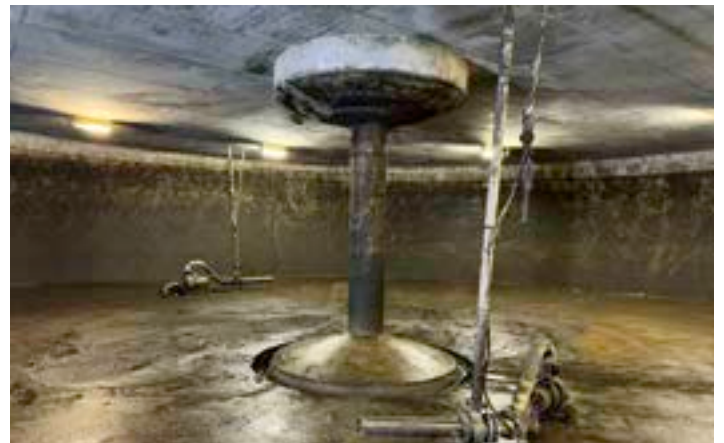
Umbau RÜB 1 in Pyrbaum
