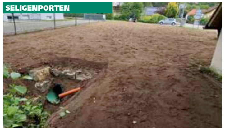
Graben verrohrt in der Möninger Straße
