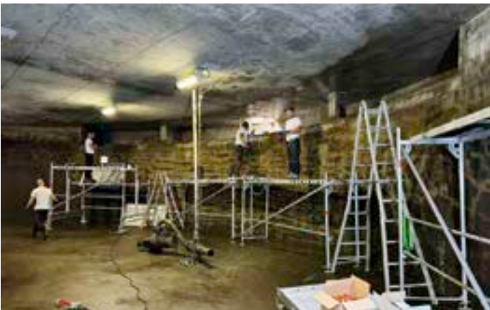
Umbau RÜB 1 in Pyrbaum
