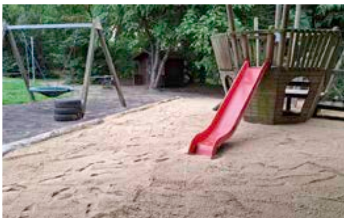
Im Kindergarten Rasselbande wurde der Außenbereich renoviert
