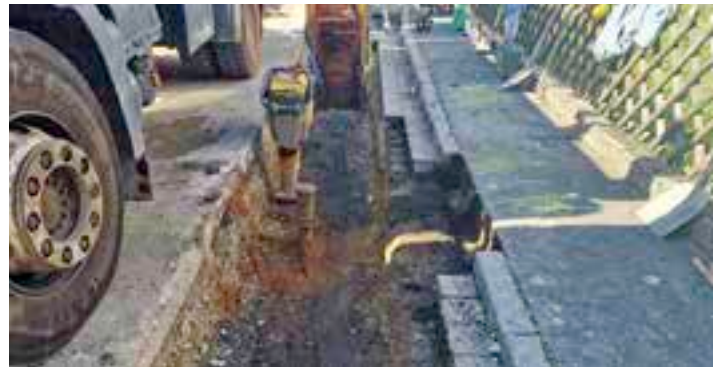
Danziger Straße: Erneuerung der Wasserleitung, des Gehwegs und der Straße
