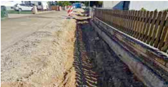
Königsberger Straße: Erneuerung der Wasserleitung, des Gehwegs und der Straße
