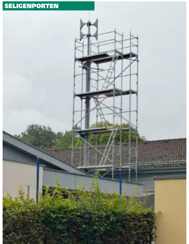
Gerüst für die Sirenenwartung errichtet
