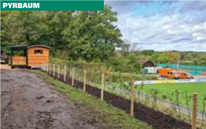
Hecke und Zaun für den Waldkindergarten angelegt
