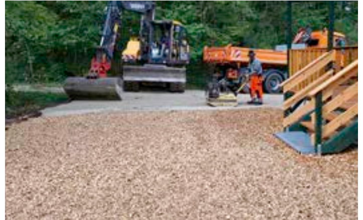
Vorplatz für den Waldkindergarten errichtet
