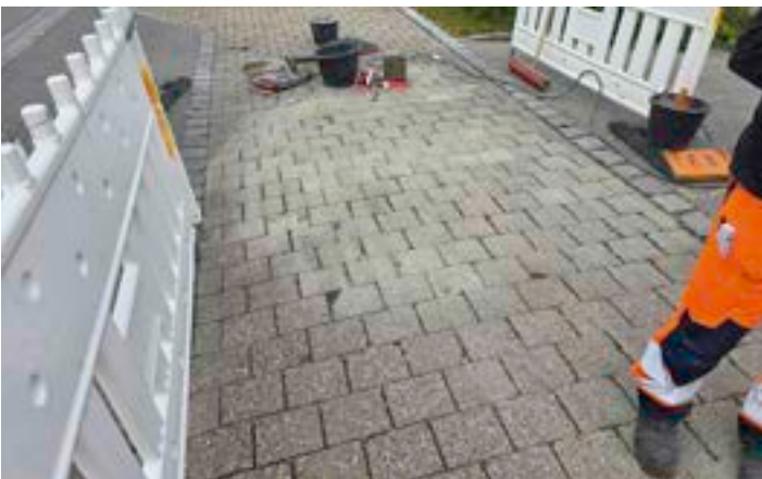
Neumarkter Straße: Gehwegpflaster wird repariert
