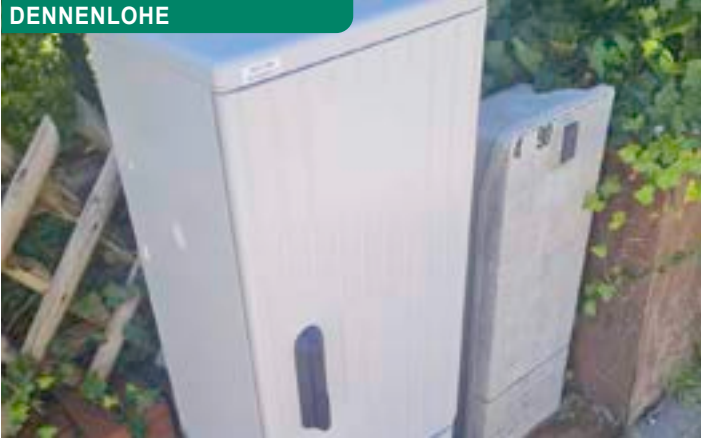
Erneuerung der Pumpstation
