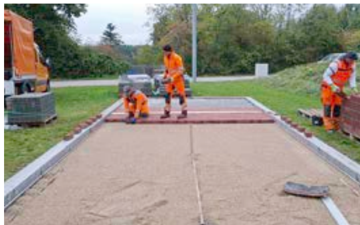
Eisstockbahn: Belag erneuert
