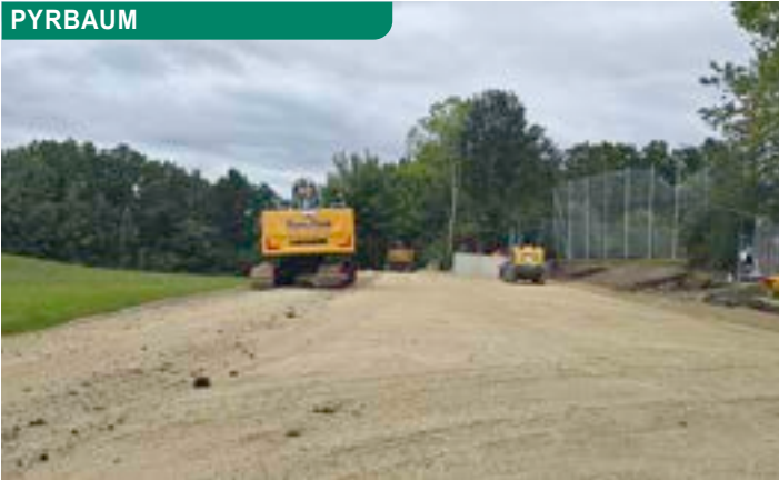
Außenbereich der Schule wird angelegt
