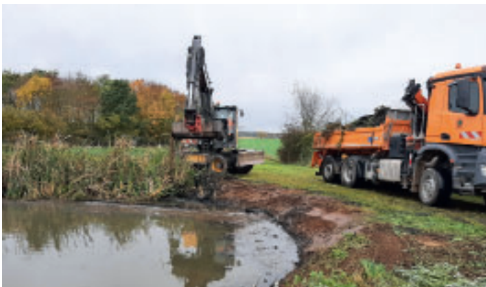
Kläranlage Schwarzach: Bewuchs vom Becken entfernt
