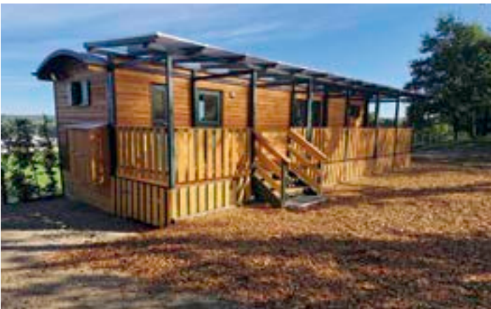
Waldkindergarten wurde zwischenzeitlich zur Nutzung freigegeben
