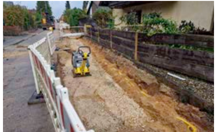
Tannenstraße: Erneuerung der Leitungen, des Gehsteigs und der Straße
