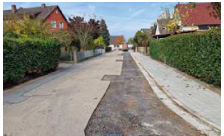
Espanstraße: Erneuerung der Straße, des Gehwegs und der Leitungen
