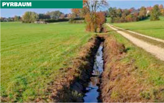
Gräben geputzt in der Lach
