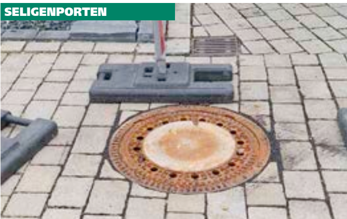
Defekten Schachtdeckel am Friedhof erneuert
