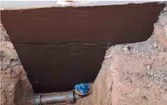
Kellerwand am Sparkassengebäude abgedichtet
