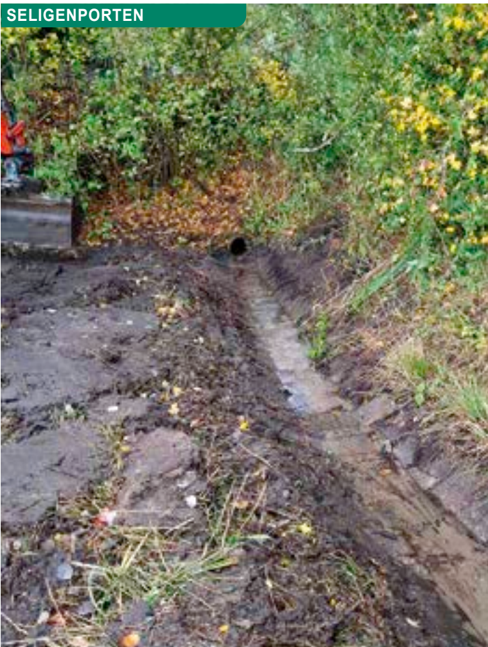
Graben geputzt unterhalb der Sonnenstraße
