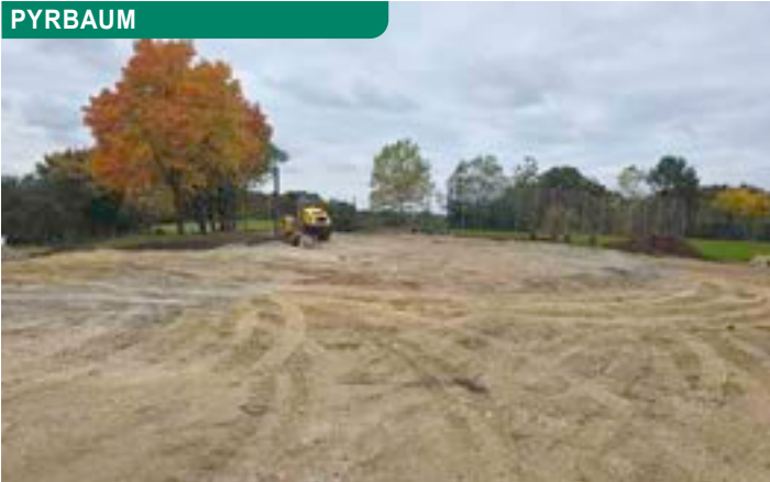
Außenanlagen der Schule werden vorbereitet
