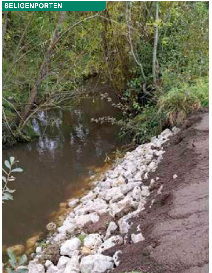
Uferbefestigung an der Schwarzach
