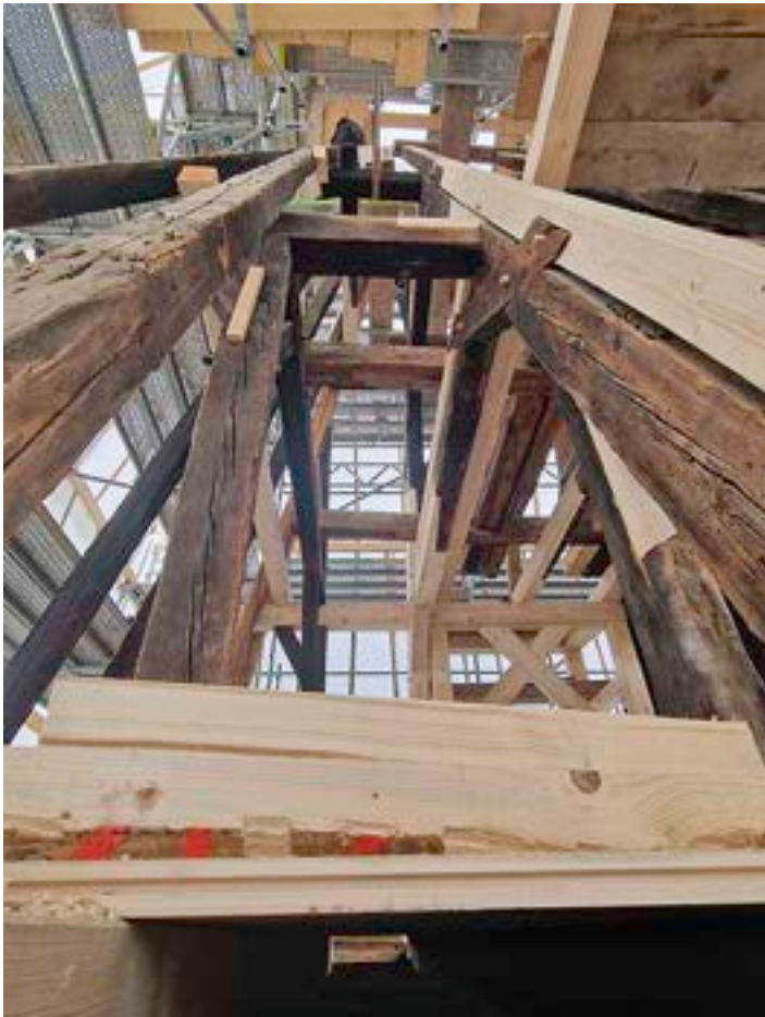
Seligenporten: Sanierung des Torturms
