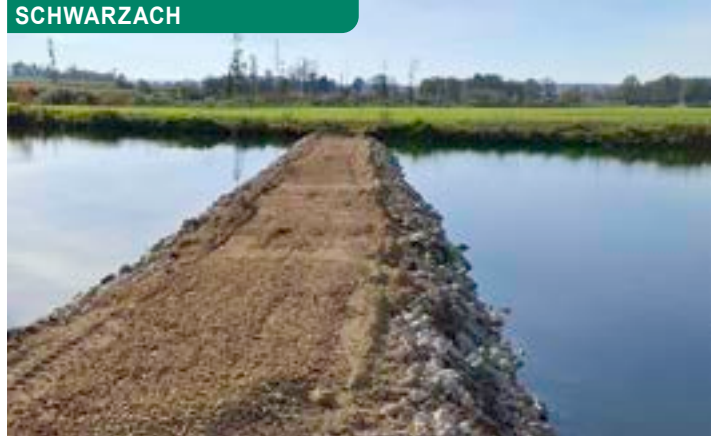
Dammbefestigung Kläranlage
