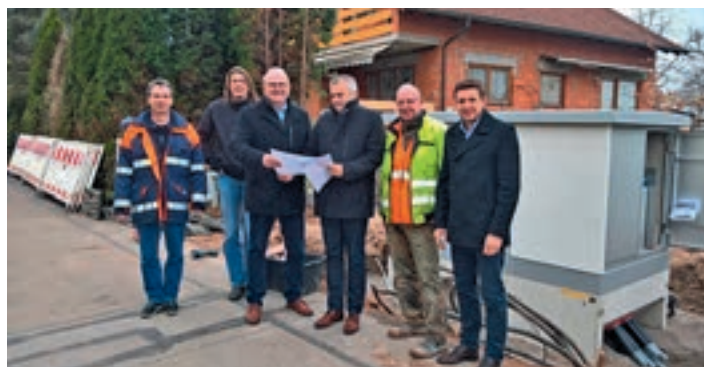
1. Bürgermeister Guido Belzl und Marktbaumeister Gunther Pfahler mit den Vertretern des Bayernwerks vor der neuen Kompakt-Trafostation in der Jahnstraße Seligenporten
