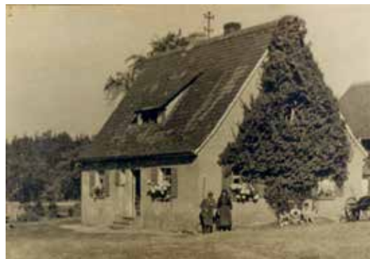
Oben: Das alte „Tagwerkerhaus“ ca. 1960. Dieses Haus wurde ca. 1965 durch eine neues ersetzt.
