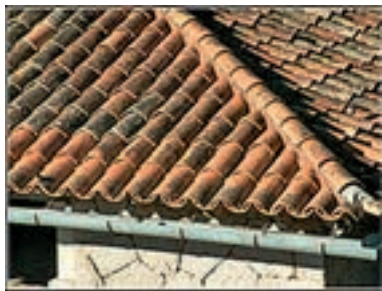
Dacheindeckung mit Mönch und Nonne
