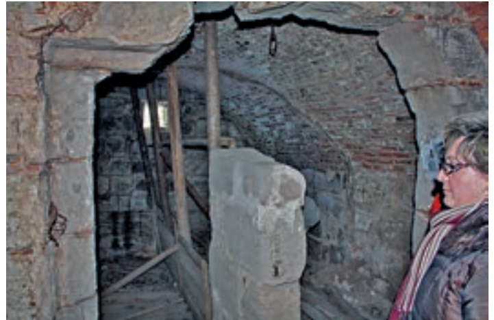
Kellergewölbe aus Backsteinen im Kirchenstadel im „Urzustand“.
