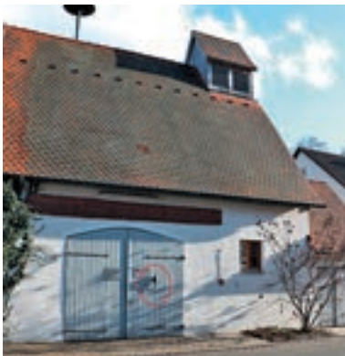
Gerätehaus der FFW Oberhembach in der Zwingstraße
