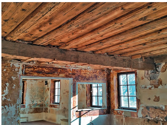
Freigelegte Wände und historische Bohlen-Balken-Decke im Ostrakt der Bräustuben (ehem. Gaststätte)
