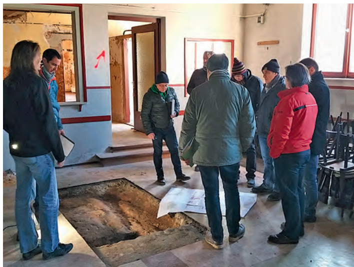
Ortstermin im Saal der Bräustuben mit den Planern (hier: freigelegter Scheitelpunkt des Gewölbekellers)
