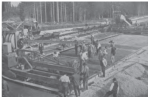
Das Bild zeigt eine Autobahnbaustelle beim Einbringen der Betondeckschicht. Im Hintergrund sind die Schmalspur-Bahn mit Dampflok zu erkennen. Außer dem sind die Kipporen zu sehen. Im Vordergrund sind die Betonfertiger mit Mischmaschinen.
