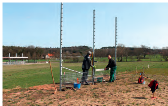
4 Meter ragen die Pfosten des Ballfangzauns in die Höhe: Damit ist ein weiteres Projekt beim Sportplatzbau des TSV Pyrbaum an den Start gegangen.
