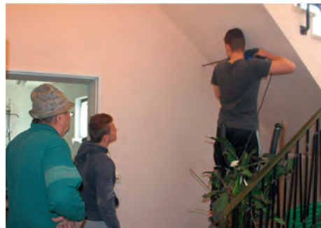
Unter fachkundiger Anleitung von Fred Döbl verlegen die TSV-Fußballer Wasser und Strom in den alten Gymnastikraum, der zu einem Physio-Raum umfunktioniert wird.
