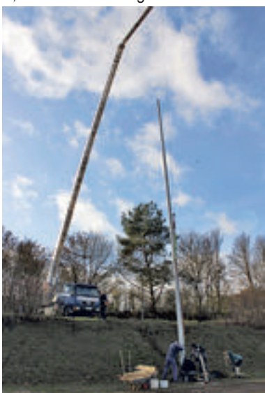
Ein Highlight war das Aufstellen der Flutlichtmasten im November beim TSV Pyrbaum
