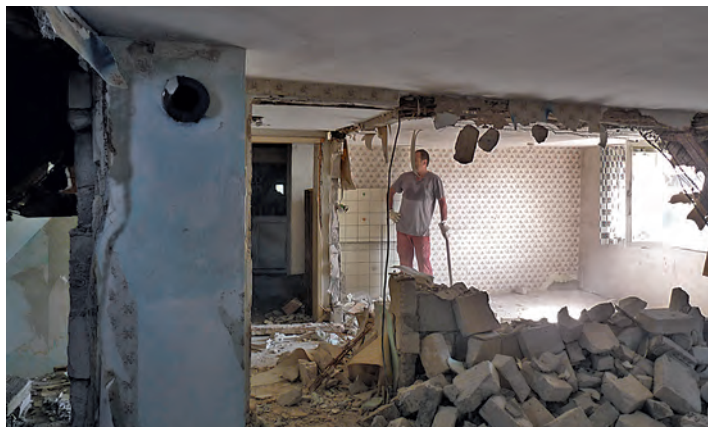
Der Heimatverein hat inzwischen das Hausinnere von den Einbauten des 20. Jahrhunderts befreit.
