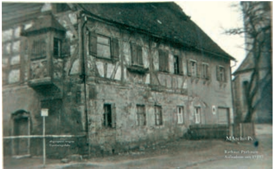
Das Bild zeigt den Nordteil des Rathauses ca. 1948. Oben links ist noch der Bretterverschlag infolge der Kriegsschäden zu erkennen.
