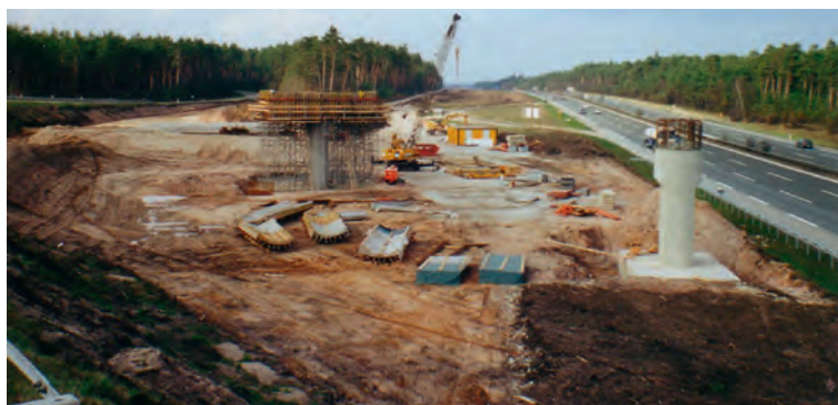
Neubau der Brücke der Staatsstraße 2225 über die Autobahn und ICE.
