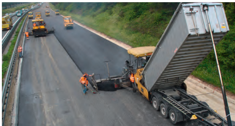
Bereits im Jahre 2006 wurde dann die gesamte Fahrbahndecke der A 9 erneuert.
