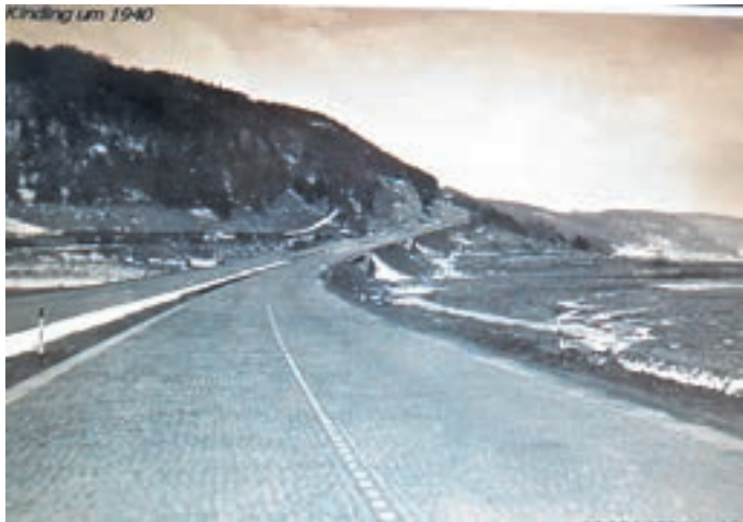
Das Bild zeigt die Autobahn am Kindinger Berg. Steigungen wurden damals gepflastert. Diese Steigungen -Kindinger Berg und Hienberg- waren damals von den Lkw-Fahrern gefürchtet. Die Zugmaschinen hatten noch unter 100 PS und mancher Kühler kochte über. Vor allem auch im Winter wegen des Glatteises. Ein Salz streuen gab es noch nicht.
