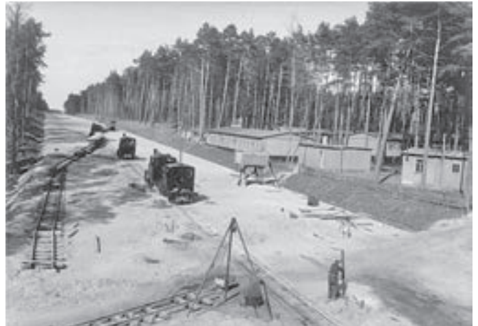
Das Bild zeigte eine Autobahnbaustelle mit Schmalspurbahn und ein Arbeiterlager. Aufgrund der vorhandenen Kiefernwälder könnte die Aufnahme in unserer Gegend gemacht worden sein.
