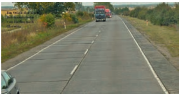
Ein Stück alte Reichsautobahn im heutigen Polen kurz vor Gleiwitz, Strecke Berlin-Breslau-Gleiwitz, im Jahre 2005. Hier sind die gegossenen Betonplatten und die Seitenstreifen klar zu erkennen
