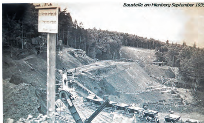
Baustelle am Hienberg September 1935
