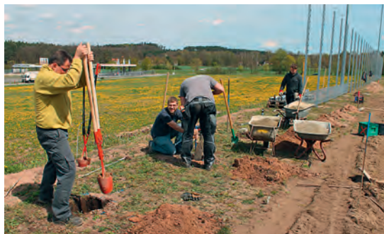
Jedes Fundamentloch muss in Handarbeit noch nachgegraben werden, um die erforderlichen Abmessungen für die Fundamente zu garantieren.
