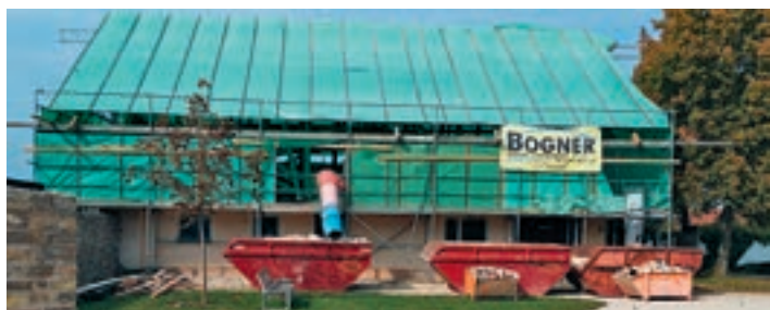
Die Sanierung des denkmalgeschützten „Schusterhauses“ in Seligenporten ist in vollem Gang.
